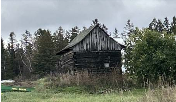
En pièce sur pièce avec larmiers retroussés. 717, Société, Saint-Jean-de-Dieu
