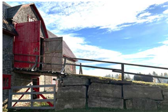
Pont sur un mur gouttereau avec lucarne 33, rue Principale, Saint-Jean-de-Dieu
