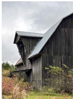
Lucarne proéminente à pignon. 25, route Neuve, Sainte-Rita.
