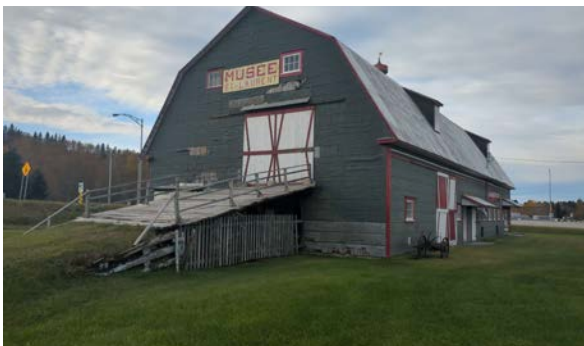
Avec pont d'accès dans le mur pignon. 552, Notre-Dame, Notre-Dame-des-Neiges
