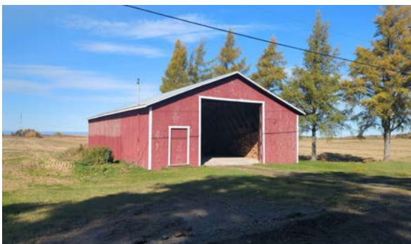
Porte imposante dans le mur pignon. 3e Rang, Saint-Éloi.
