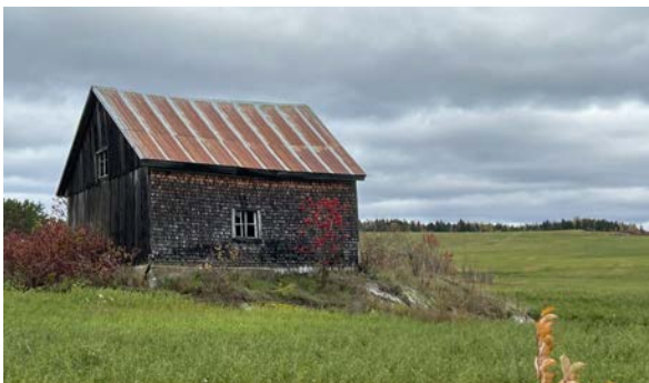
Avec planche verticale et bardeau de bois. route 293, Saint-Jean-de-Dieu
