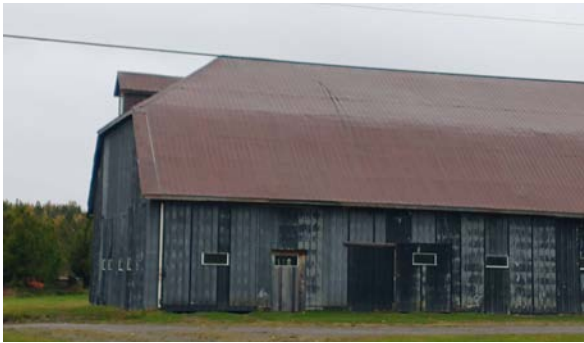
Grange-étable à toit à demi-croupe avec lucarne 27 route 132, Saint-Simon-de-Rimouski
