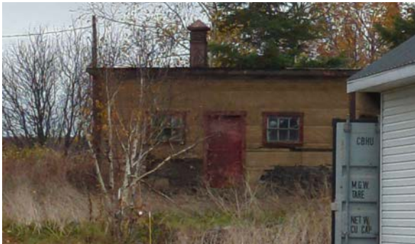
Toit à un versant avec évent. 7e Rang, Saint-Médard
