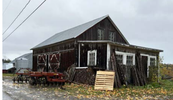
Possible ancienne maison transformée en fournil. 762, 1er Rang, Saint-Simon-de-Rimouski
