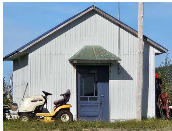
Laiterie revêtue de tôle 40, rue de l'Église, Saint-Simon-de-Rimouski
