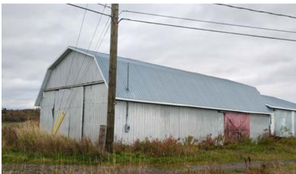
Toit à dos d'âne, portes coulissantes. 56, 2 e Rang, Notre-Dame-des-Neiges
