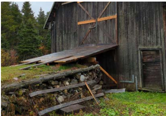
Structure en pierre et bois. Dans un mur pignon. 17, Côte-du-Bic, Sainte-Françoise
