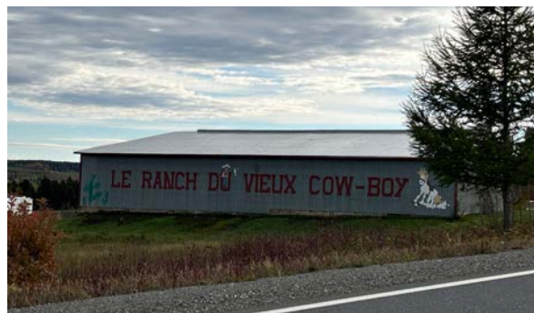
À toit à une seule pente. Grande-Ligne, Saint-Clément
