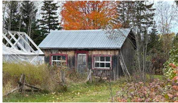
Avec porte centrée sur mur gouttereau. 208, Sainte-Anne, Saint-Clément
