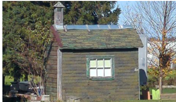
Recouvert de bardeau d'asphalte, avec évent latéral. 210, rue Principale, Saint-Éloi
