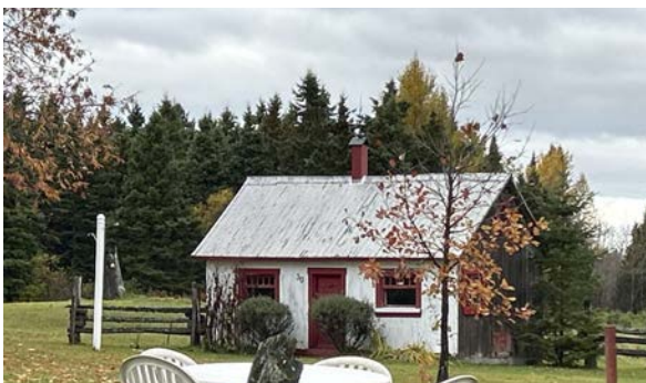
Avec petite trappe latérale et évent central. 36, Taché, Sainte-Rita
