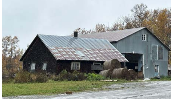
Bardeau de bois sur les façades, évent central. 25, 5e Rang, Saint-Mathieu-de-Rieux
