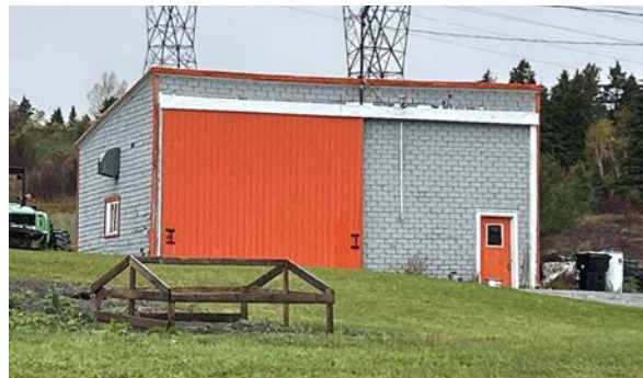
À toit à une seule pente. 232, 3e Rang, Saint-Mathieu-de-Rioux
