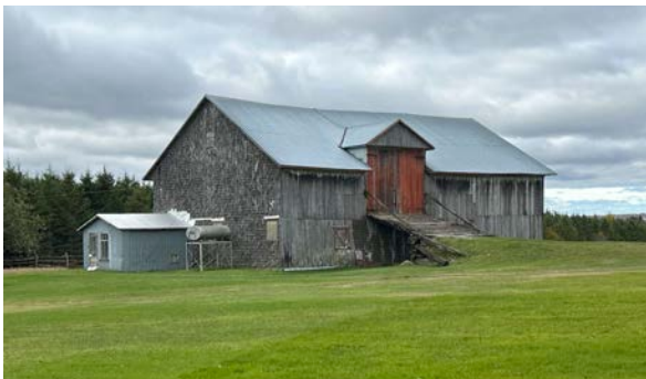
Avec bardeau de bois et lucarne d'accès à pignon. 42, 4 e Rang, Sainte-Rita
