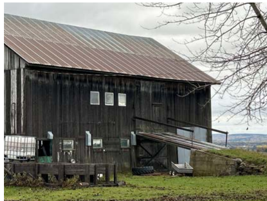
Pont sur mur gouttereau sans lucarne. 350, 8 e Rang, Saint-Jean-de-Dieu
