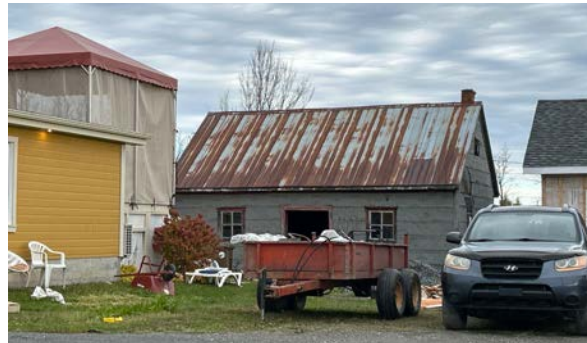
Composition symétrique et cheminée. 13, Pont, Saint-Clément
