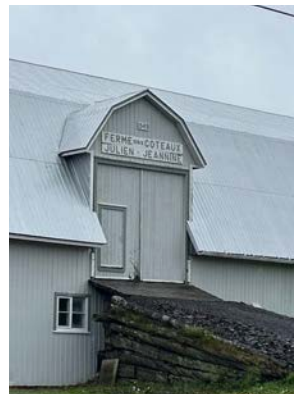
Lucarne à dos d'âne avec date de construction. 605, 3 e Rang, Saint-Mathieu-de-Rioux.
