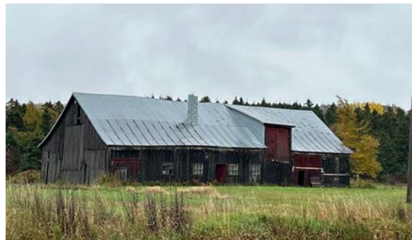
À larmier incurvé et à lucarne d'accès en chien assis. Route 132, Saint-Simon-de-Rimouski
